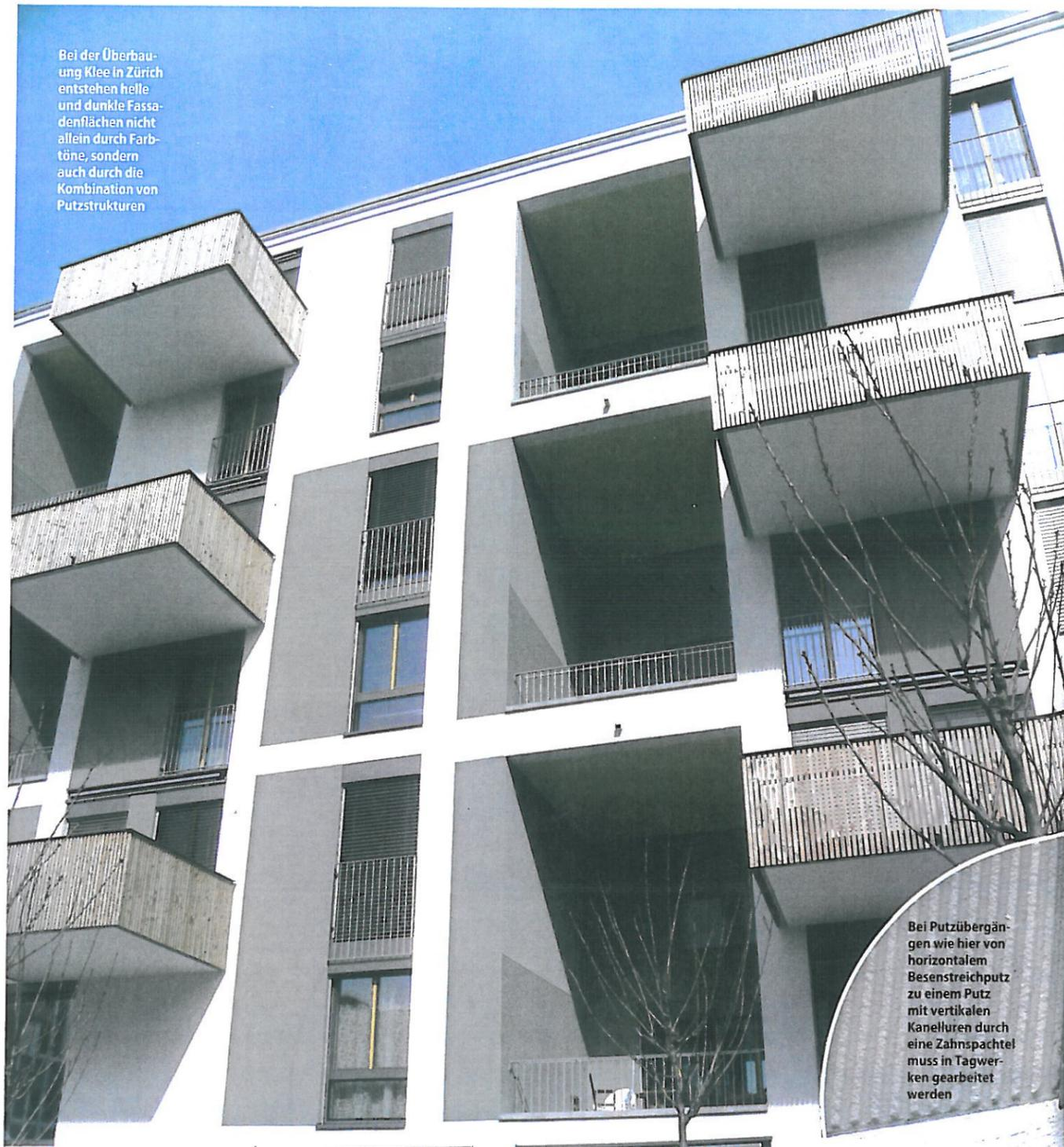
Bei Putzübergängen wie hier von horizontalem Besenstreichputz zu einem Putz mit vertikalen Kanelluren durch eine Zahnpachtel muss in Tagwerken gearbeitet werden
