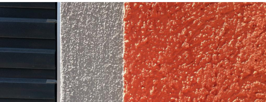
Charakteristisch für das Dämmsystem des Scheuchzerhofes ist ein dickschichtiger mineralischer Putzaufbau, kombiniert mit der zweikomponentigen Reinsilikatfarbe Keim-Purkristalat.
